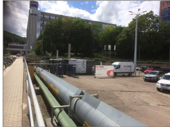
BU: Die Container mit Dampfkessel und Heizöltanks wurden mittels Festverrohrung an die vorhandene Dampfleitungstrasse (rechtes Bild) angeschlossen. (Bildquelle: Hotmobil Deutschland GmbH)
