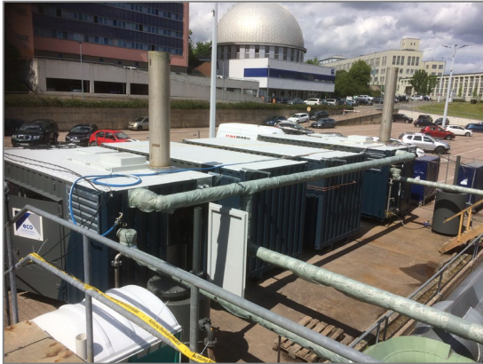
BU: Die Container mit Dampfkessel und Heizöltanks wurden mittels Festverrohrung an die vorhandene Dampfleitungstrasse (rechtes Bild) angeschlossen. (Bildquelle: Hotmobil Deutschland GmbH)
